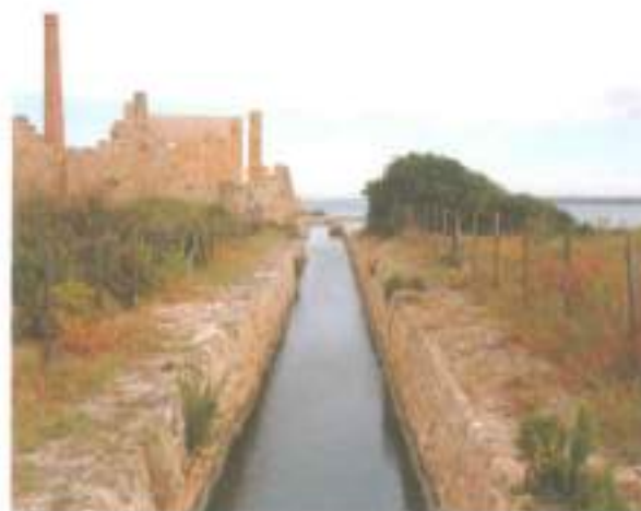
Fig. 52. P3-F4. Lo sbocco al mare del canale F, ristrutturato all'interno del progetto LIFE NATURA (foto in alto: gennaio 2006); la foto in basso (giugno 2010) mostra il recupero della vegetazione.
