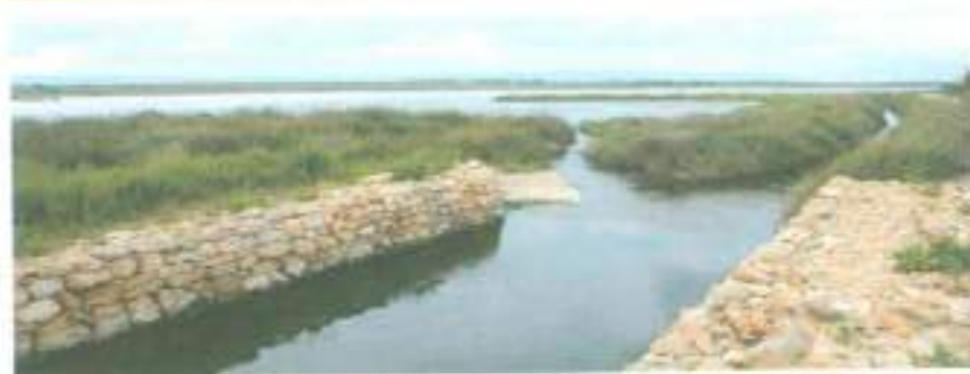
Fig. 50. P3-F1, F2, F3, la parte del sistema di canali F che è stato ristrutturato nell'ambito del progetto LIFE NATURA. La foto in alto è stata scattata nel gennaio 2006, mentre quella in basso del giugno 2010 ed evidenzia oltre al ripristino dei muretti a secco l'espansione della vegetazione di ambienti umidi sulle superfici demolate.
