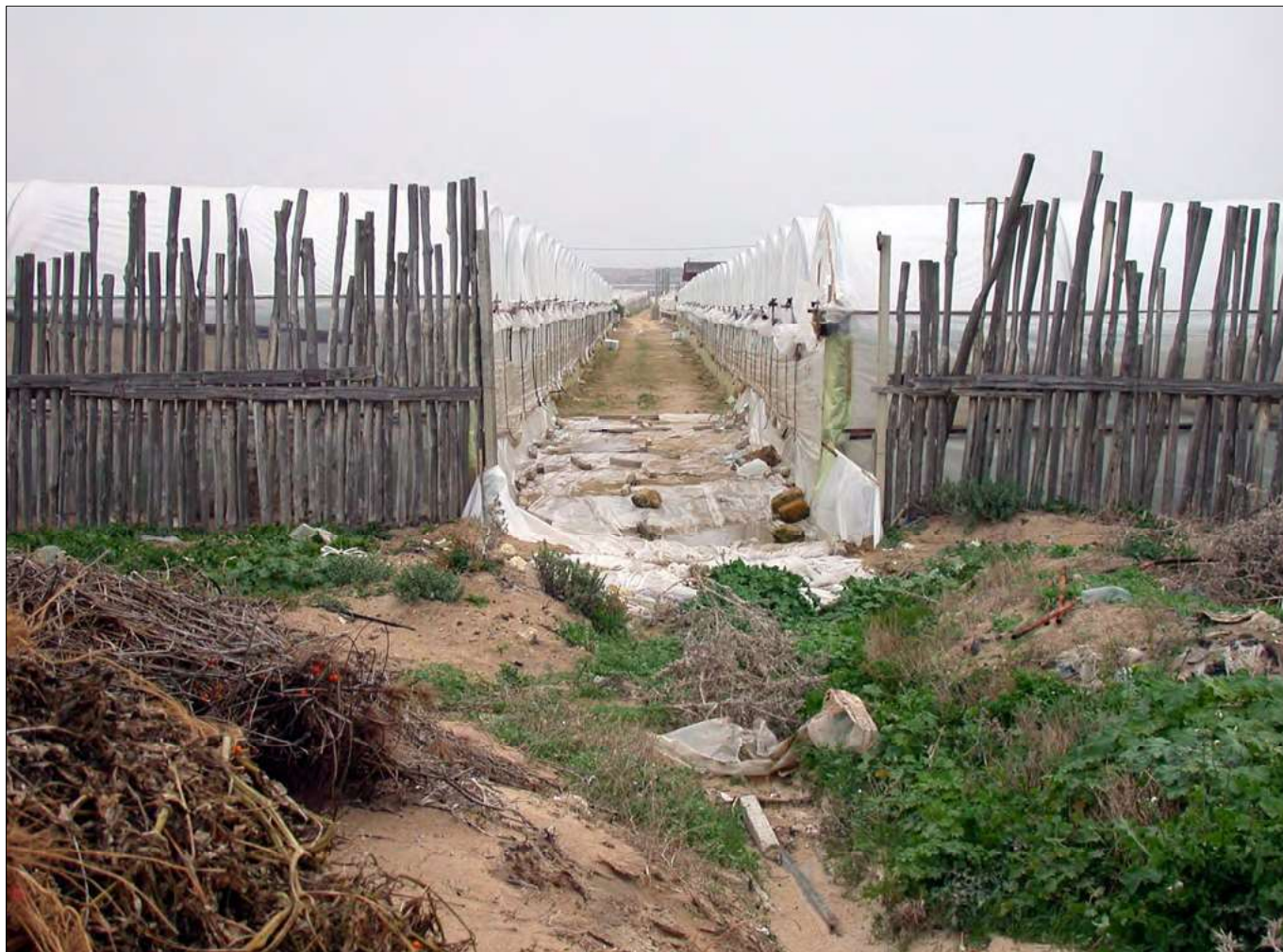
FIGURA 22. Il paesaggio delle serre: scene di ordinario degrado nell'area di Gela (foto: B. Massa).
