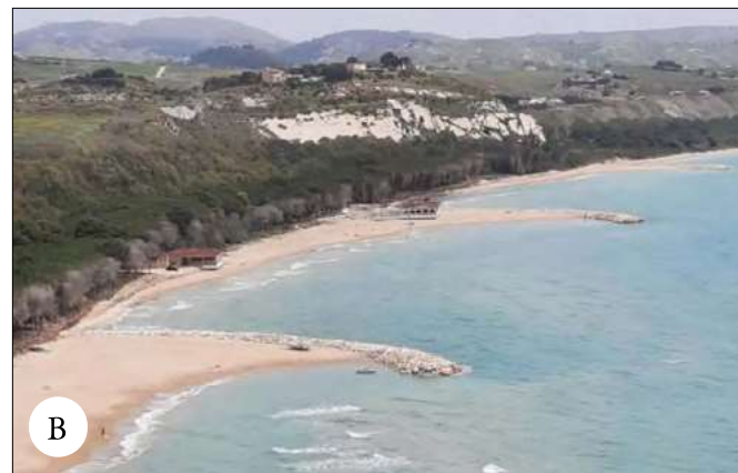
FIGURA 24. Litorale di Eraclea Minoa. (A): attività di cantiere durante la realizzazione di una delle barriere frangiflutto ( https://www.guidasicilia.it/notizia/c-era-una-volta-la-spiaggia-di-eraclea-minoa-e-tornera-ad-esserci/3018156 ); (B): visione d'insieme delle tre barriere frangiflutto ( https://qds.it/eraclea-minoa-viaggi-camion-rifare-spiaggia/amp/ ); si noti come le mareggiate abbiano rimaneggiato la duna e provocato la morte dei pini più vicini alla spiaggia.
